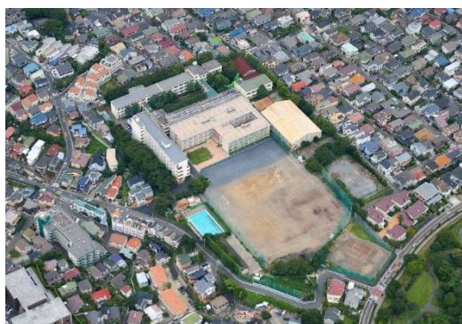
新校舎の後ろの旧本館と北館
